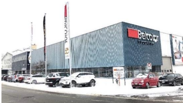
St. Gallen, Zürcherstrasse 493
