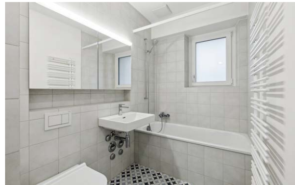
Nasszelle nach Sanierung
