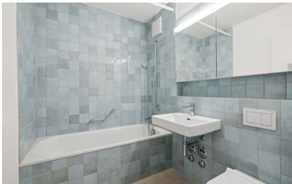
Nasszelle nach Sanierung
