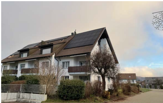
Aussenansicht nach Erneuerung
